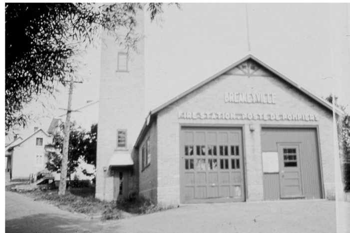
Poste à incendie en 1954
