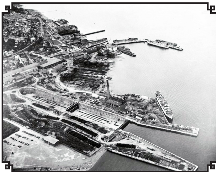
Vue aérienne du chantier Davie
